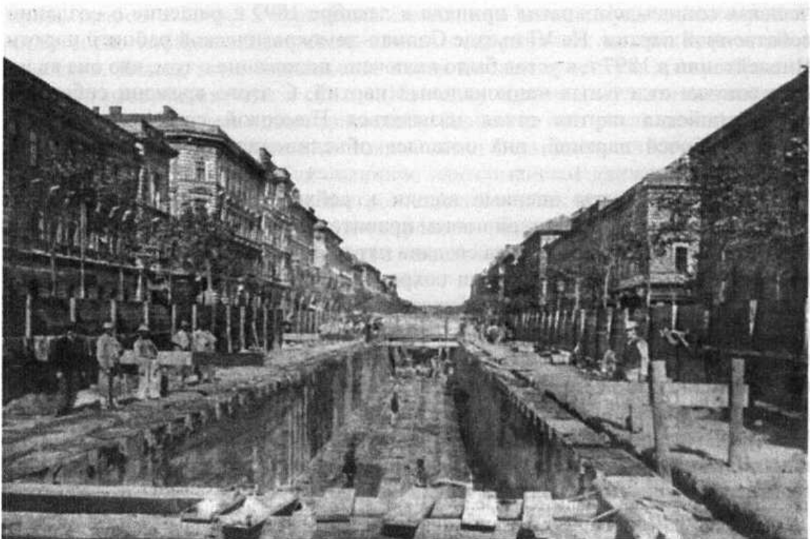
Строительство метро в Будапеште. 1896 г.
